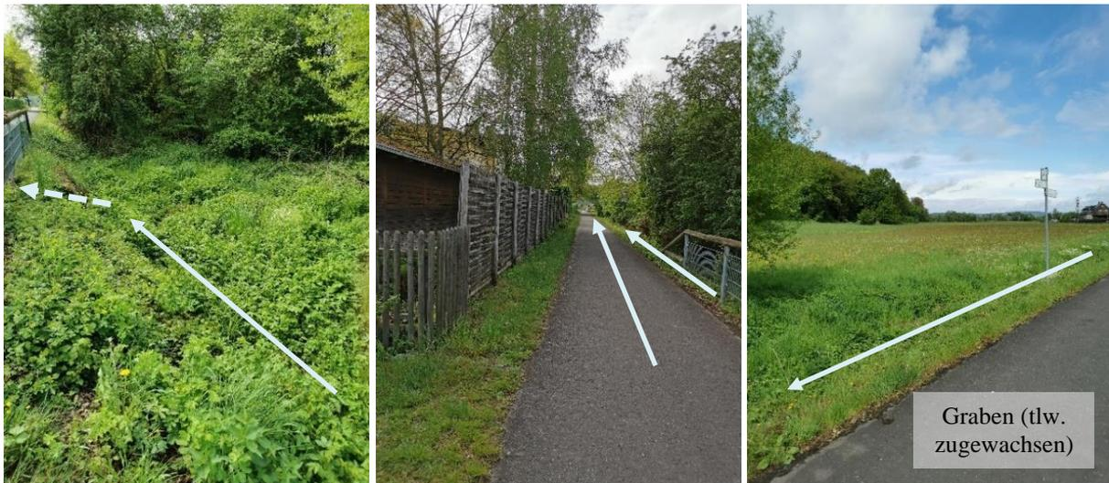
Abbildung 16: Fließwege von Niederschlagswasser über den Graben seitlich des Maare-Mosel-Radweges.
