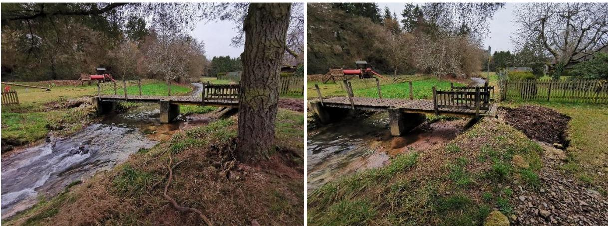
Abbildung 2: Schäden durch das Hochwasserereignis vom 14./15. Juli 2021 an der Fußgängerbrücke und am Ufer im Bereich des Spielplatzes Niederkail.
