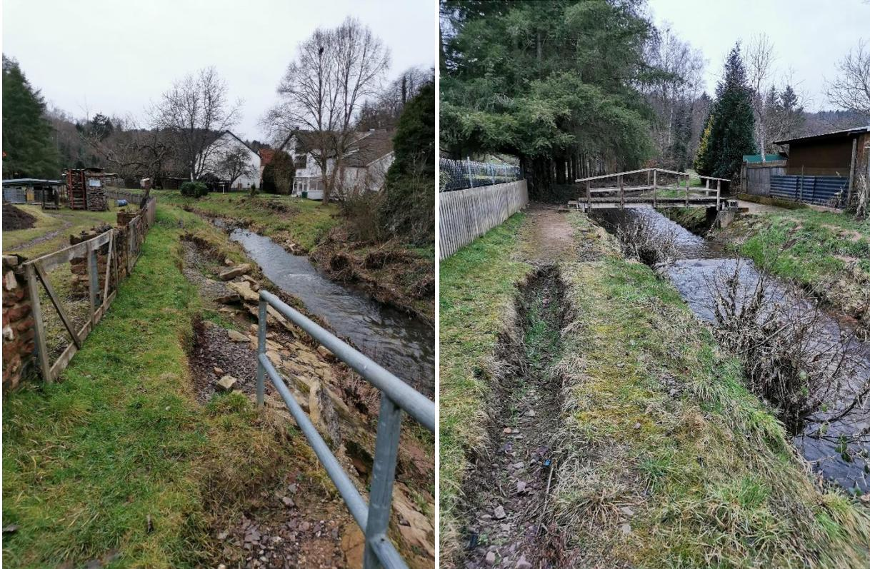
Abbildung 3: Schäden durch das Hochwasserereignis vom 14./15. Juli 2021 am Fußweg entlang des Kailbachs in der Ortslage Niederkail.
