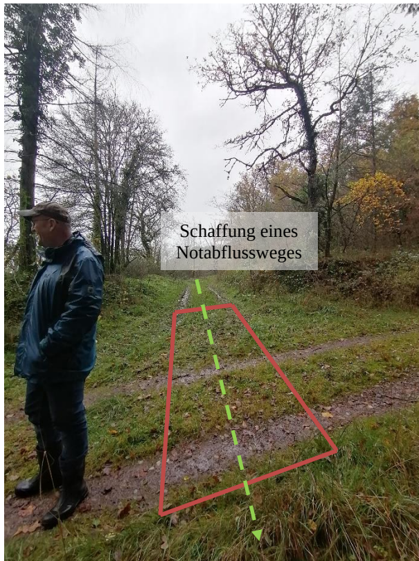
Abbildung 17: Vorgeschlagene Lage der vliesummantelten Krotzenpackung zur Lenkung des Oberflächenabflusses im Außengebiet der OG Bruch.
