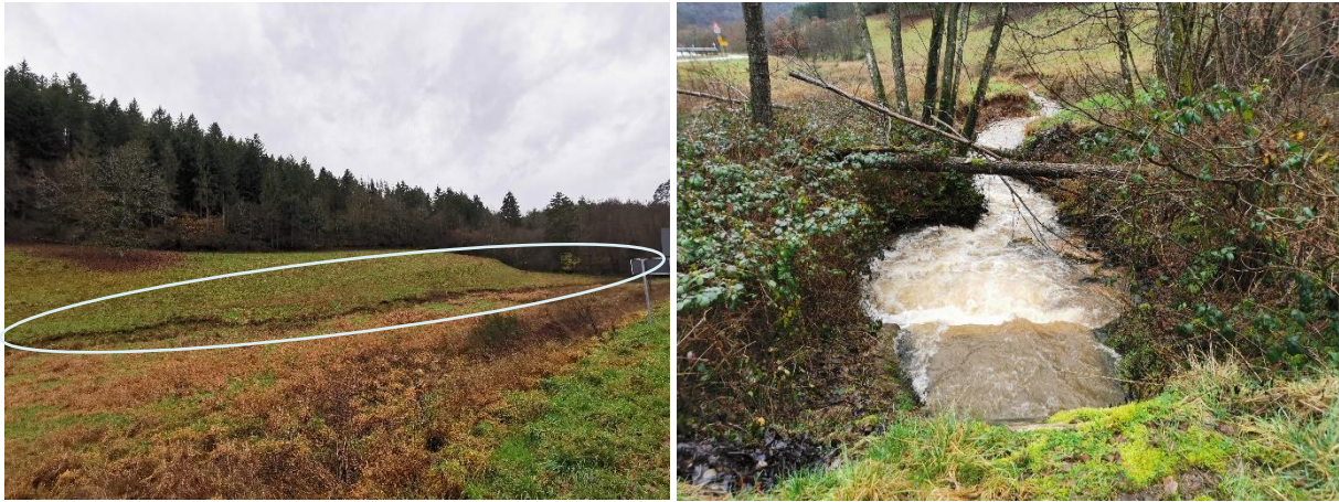
Abbildung 18: Verlauf des Dörbaches westlich von Bruch mit deutlicher Tiefenerosion im Gewässerbett.
