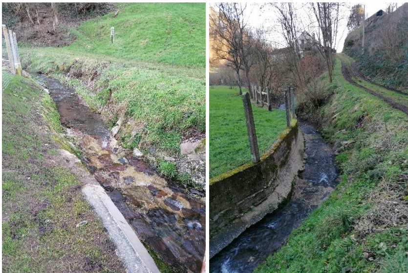
Abbildung 14: Sohlbefestigung und Uferverbau des Bärbaches im Bereich von In der Katz.
