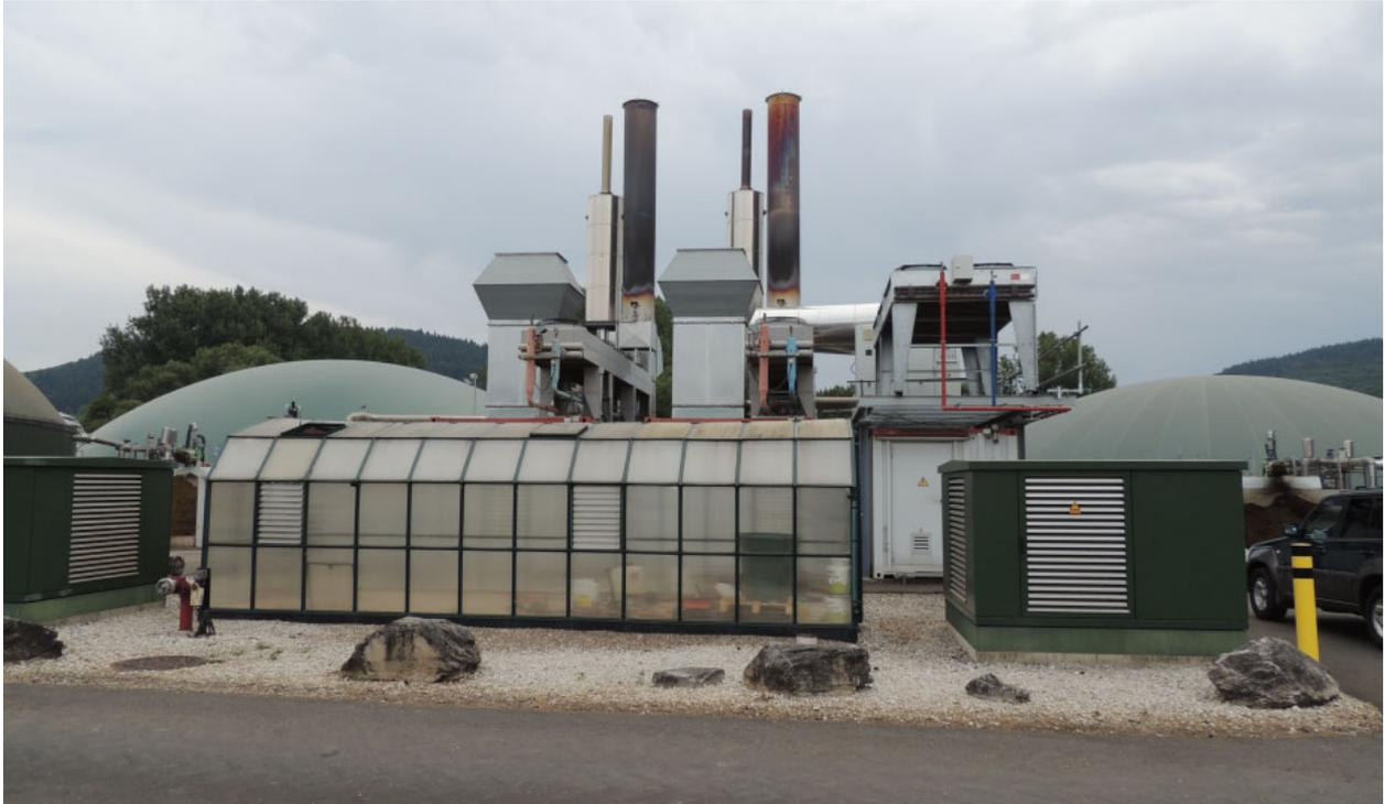
Abbildung 4-2: Blick nach Osten auf das Generatorhaus der Blockheizkraftwerke 1 und 2. Rechts und links sind die Gärbehälter und die Folienspeicher zu erkennen.
