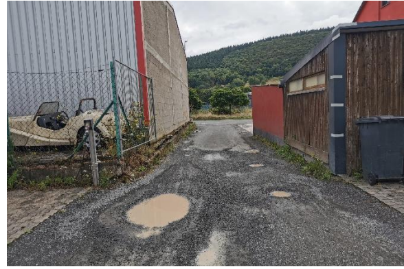
Abb. 11: Teilversiegelter Hofplatz (HT1 tv), welcher die Betriebsfläche an die Gemeindestraße „Walholzerstraße“ anbindet. (Foto: Stra-tec GmbH, 22.05.2023).
