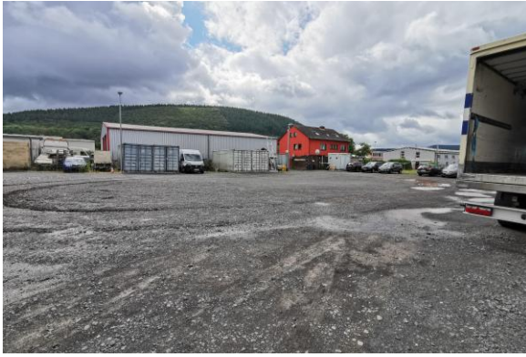
Abb. 10: Teilversiegelter, geschotterter Lagerplatz (HT4) auf dem Gelände der Firma Göhlen. (Foto: Stra-tec GmbH, 22.05.2023).
