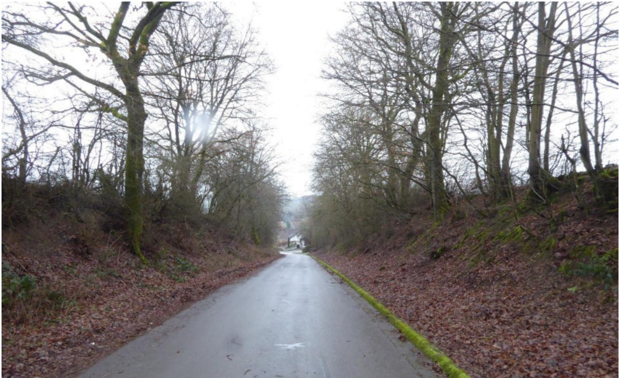
Abb.: betroffene Wallhecke auf rechter Seite mit Blick zum Ort hin
