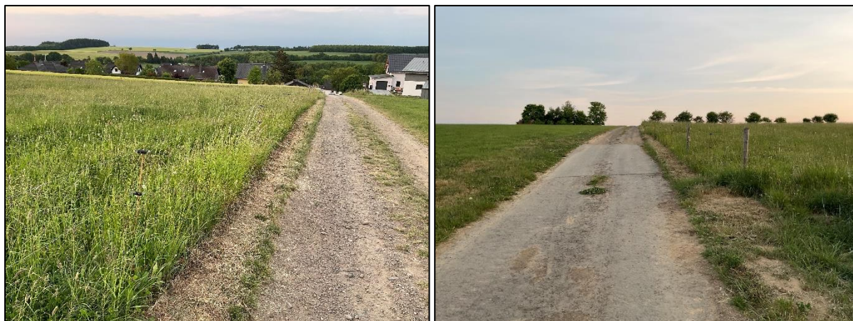
Abbildung 5: geschotterter Wirtschaftsweg mit asphaltiertem Teilstück im Westen
