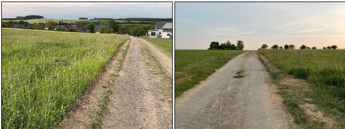
Abbildung 4: Geschotterter Wirtschaftsweg mit asphaltiertem Teilstück im Westen
